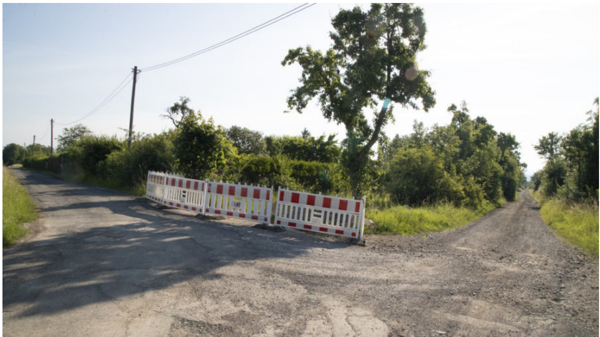
Abb. 17: Blick zur Stadt Links Eichenweg / Rechts Weiße-Haus-Chaussee
