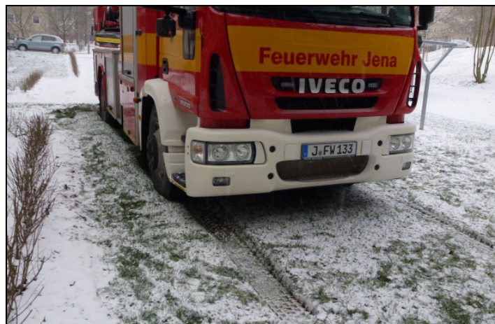
Abb. 12 - Spurrillen bei Schotterrasen [7]
