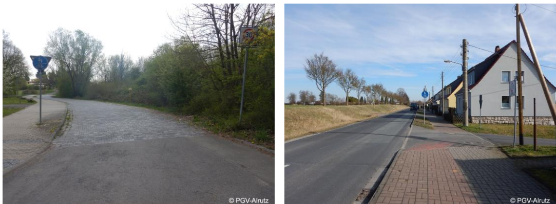
Abb. 2-2: linksseitige Benutzungspflicht in T30-Zone, Ziegelweg (links); benutzungspflichtige Anlage in der Bollstedter Landstraße bei geringem DTV-Wert (rechts)
