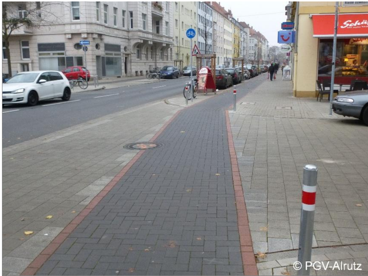
Abb. 4-16: Teilpflasterung im Einmündungsbereich einer Nebenstraße (Hannover)
