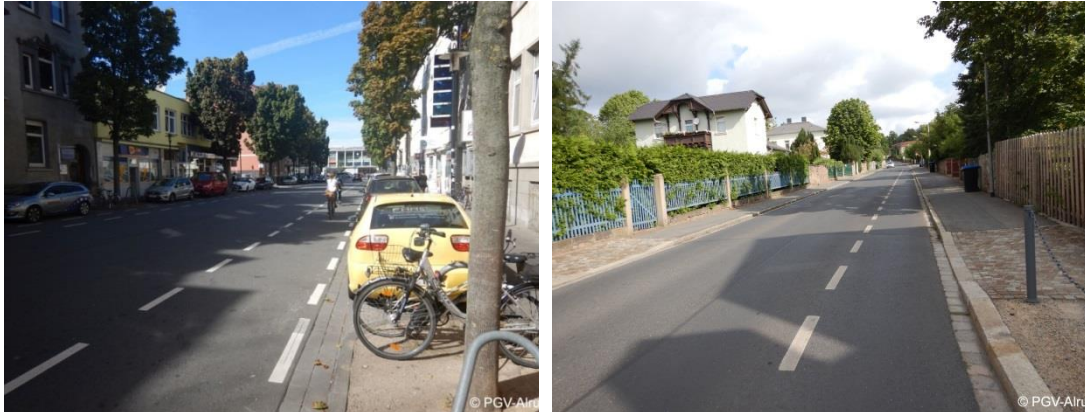
Abb. 4-12: Links: Schutzstreifen mit Sicherheitstrennstreifen zu parkenden Kfz (Hildesheim); rechts: Einseitiger Schutzstreifen (Radebeul, Moritzburger Straße)
