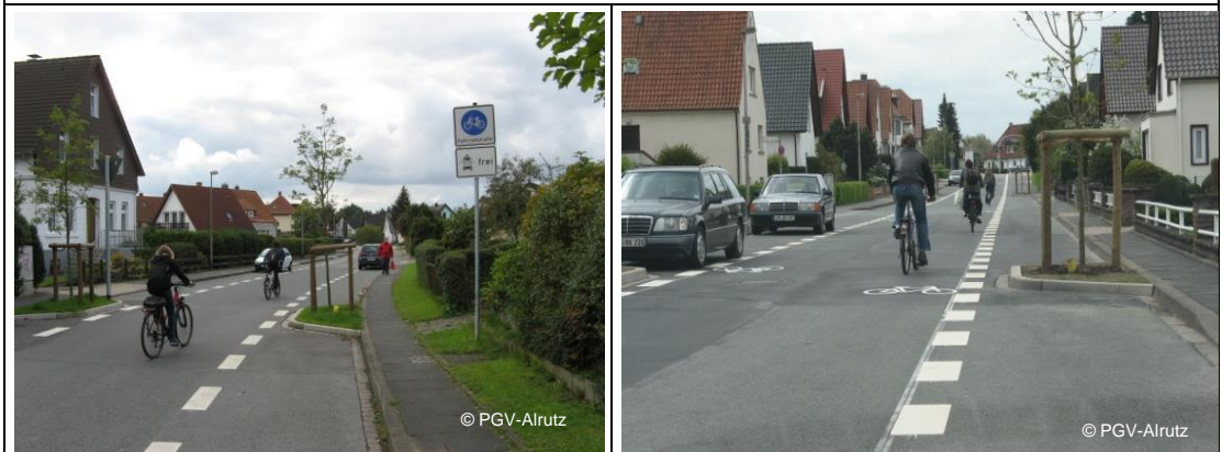
Beispiel Lemgo Fahrgasse (3,5-4 m breit) mit Breitstrichmarkierung (1 m Strich, 1 m Lücke); punktuelle Gehwegnasen zur Unterbrechung des linearen Parkens am Fahrbandrand
