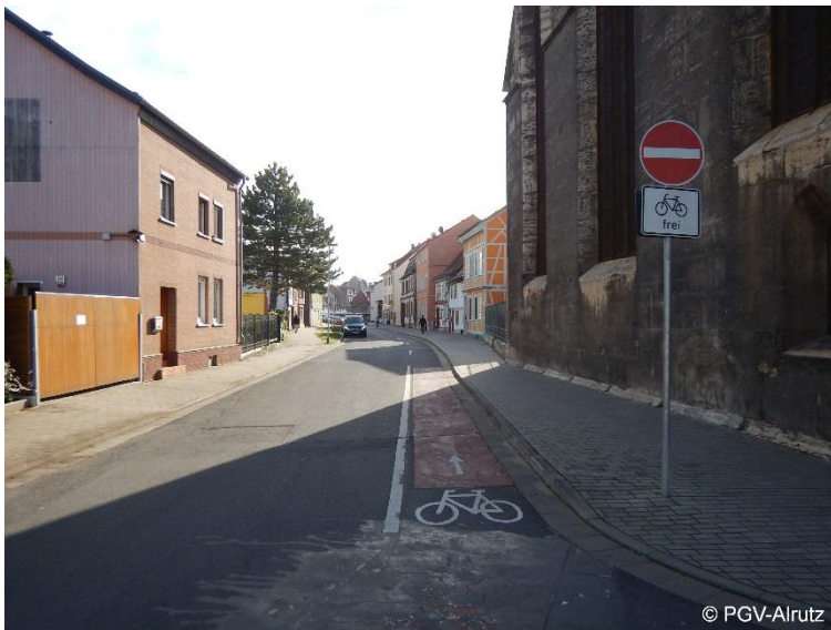
Abb. 4-27: Für den Radverkehr in Gegenrichtung geöffnete Einbahnstraße (Sonderhäuser Straße)
