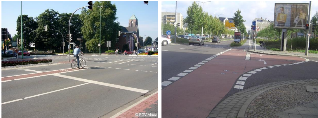
Abb. 4-21: Beispiele für direktes (links, Bocholt) und indirektes (rechts, Leipzig) Linksabbiegen
