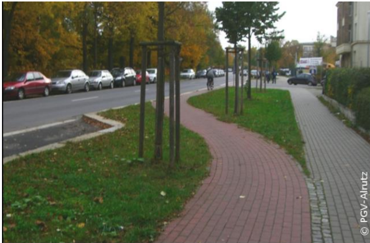
Abb. 4-15: Radverkehr wird im Vorfeld des Knotens an den Fahrbahnrand und damit ins Sichtfeld des Kfz-Verkehrs geführt
