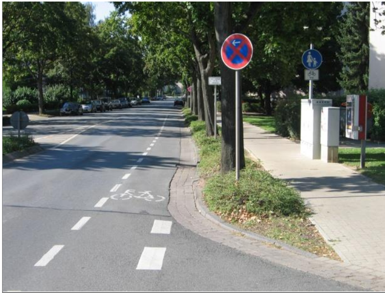
Abb. 4-13: Kombination von Schutzstreifen mit Gehweg, Radverkehr frei (Hameln)
