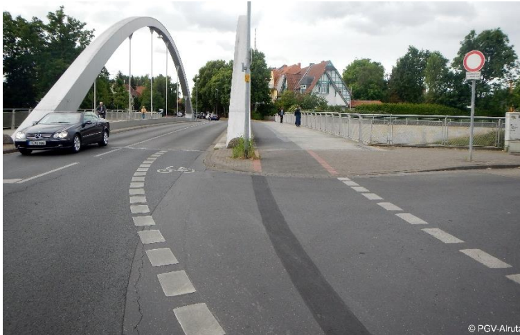
Abb. 4-9: Überleitung auf Fahrbahn (duale Führung) oder den nicht benutzungspflichtigen baulichen Radweg (Hannover)
