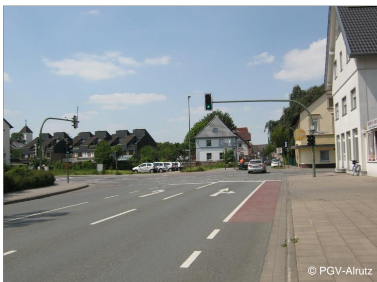
Abb. 4-18: Vorbeifahrstreifen in einer signalisierten Knotenpunktzufahrt (Bielefeld)
