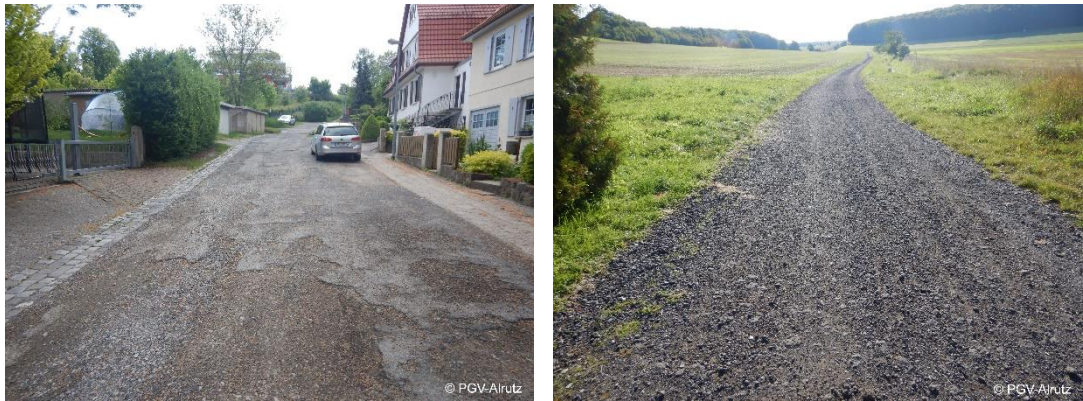
Abb. 2-5: Starke Belagsschäden am Vogteier Platz (links); Lockerer Schotter in der Verlängerung der Straße „Unterdorf“ in Eigenrieden (rechts)
