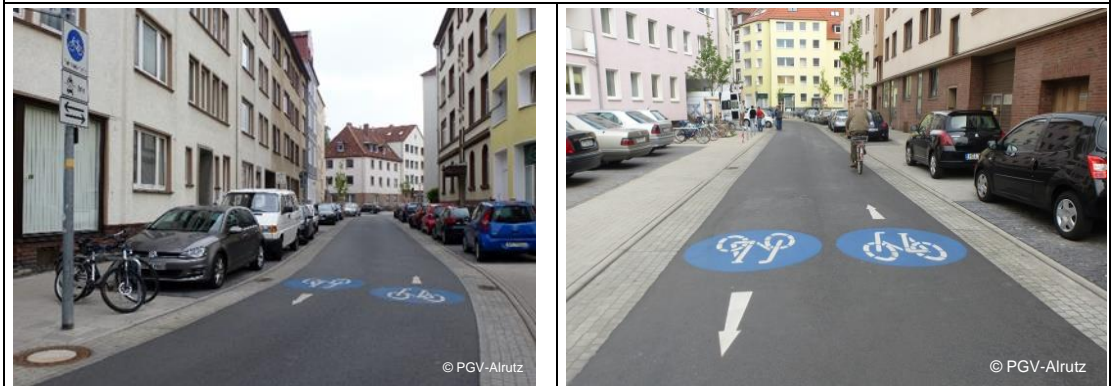
Beispiel Hannover (2) Runde Piktogramme in Blau und Richtungspfeile im Straßenverlauf. Die Rinnen zwischen der asphaltierten Fahrbahn und den Parkständen sind farblich abgesetzt gepflastert und dienen als Sicherheitstrennstreifen.
