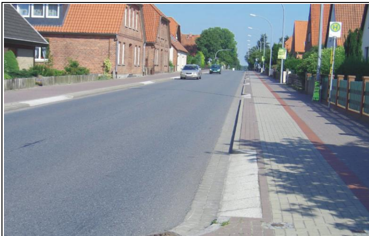
Abb. 4-4: Grundstückszufahrten mit Rampenstein (Soltau)
