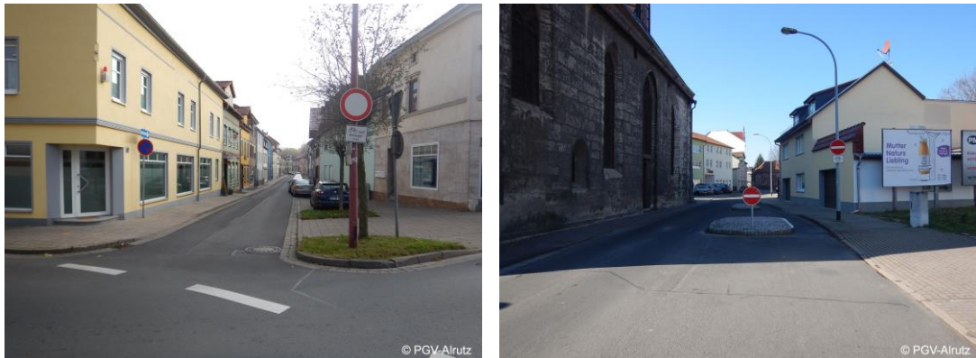
Abb. 2-9: Einfahrtverbot, Radverkehr frei in der Schaffentorstraße (links); modaler Filter in der Feldstraße (rechts)
