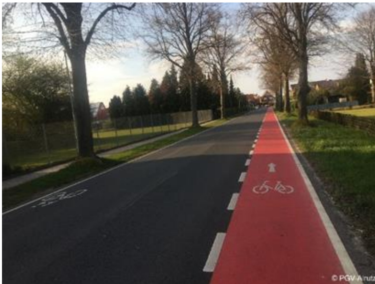
Abb. 4-28: Beispiel für gemeinsamen Einsatz eines Schutzstreifens und einer gegenüber liegenden Piktogrammreihe auf der Fahrbahn (Harenberg, Region Hannover)
