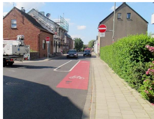
Abb. 4-34: Prinzipskizze und Beispiel (Meerbusch) zur Markierung einer Einfahrt
