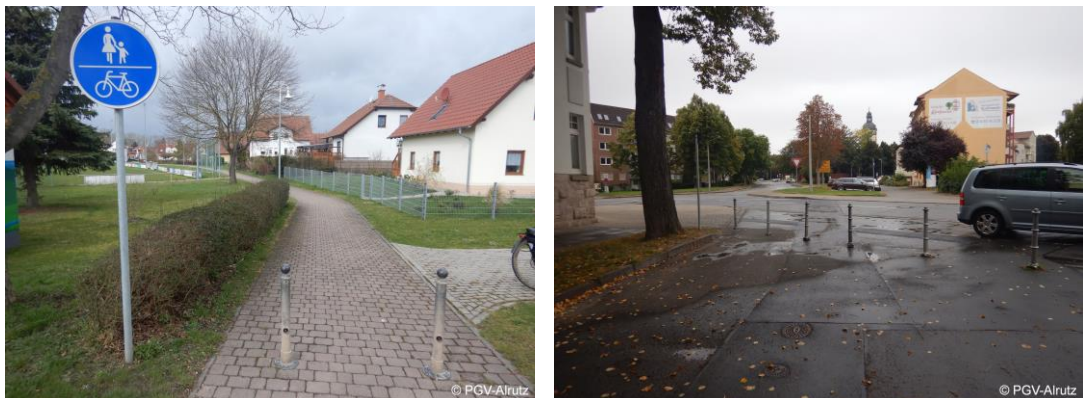
Abb. 2-6: Poller mit unzureichender Sicherung und Durchlassbreite, Am Heiligen Damm (links); August-Bebel-Straße (rechts)
