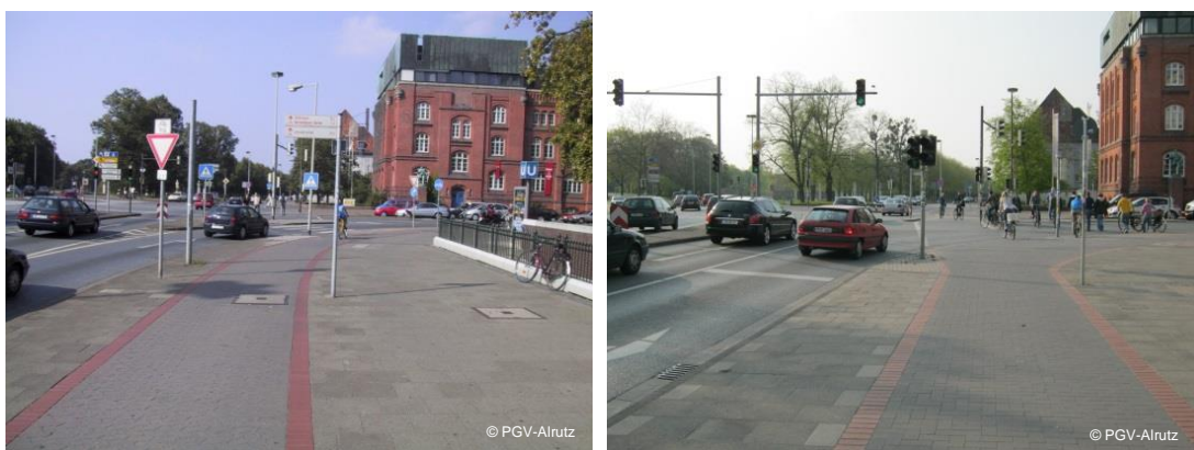
Abb. 4-19: Rückbau und Signalisierung eines konfliktträchtigen freien Rechtsabbiegefahrstreifens in Hannover (links vorher, rechts nachher)
