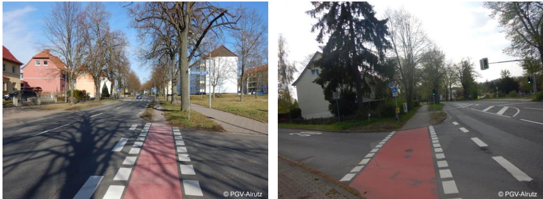
Abb. 2-1: Radverkehrsanlage in unzureichender Breite, Windeberger Straße (links); Gehweg linksseitig für den Radverkehr freigegeben, unzureichende Breite, Wanfrieder Straße (rechts)
