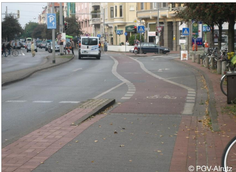
Abb. 4-17: Übergang Radweg in Radfahrstreifen an signalisiertem Knotenpunkt (Hannover)
