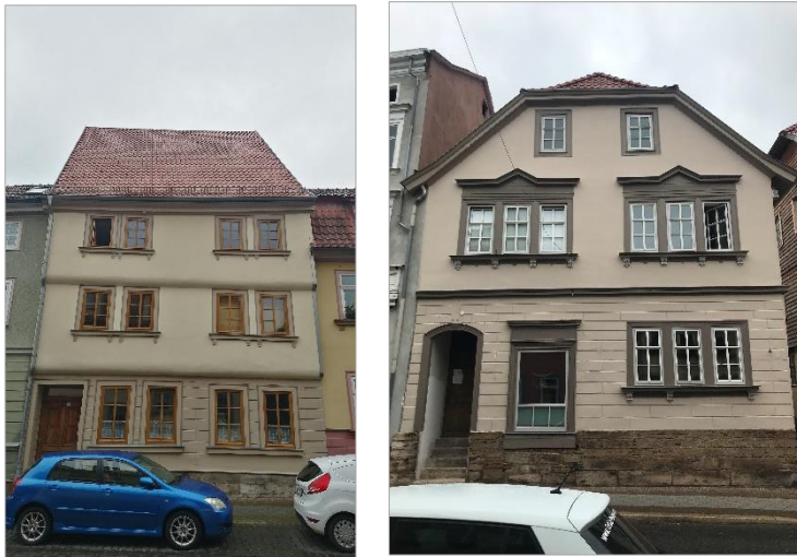
Abbildung 47: Erfurter Straße 11, 37 - saniert ohne Fachwerkreilegung
