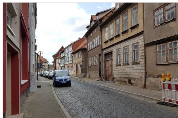
Abbildung 106: Sanierungsbedarf Wahlstraße 71 bis 75 (Quelle: ProjektStadt 2021)
