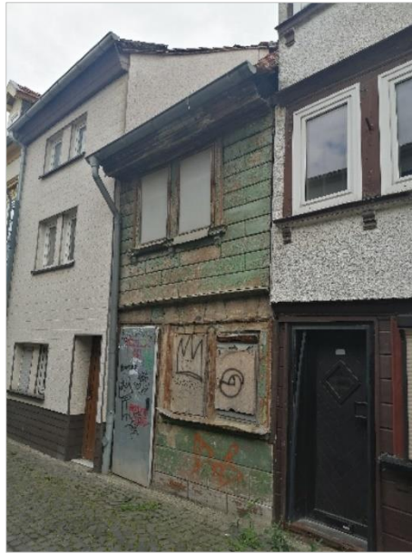
Abbildung 9: unsanierter Zustand Kleine Burgstr. 4 (Quelle: ProjektStadt 2021)
