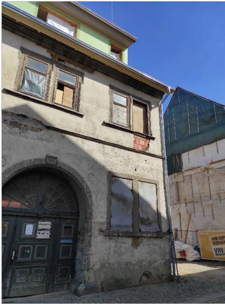
Abbildung 8: unsanierter Zustand Grasegasse 2 (Quelle: ProjektStadt 2022)
