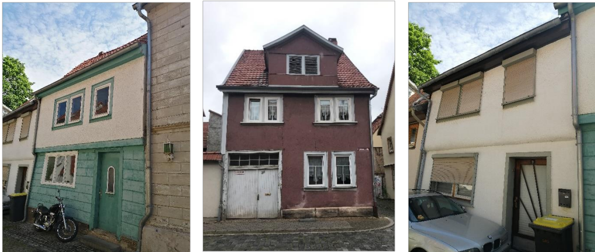
Abbildung 43: Sackgasse 2 (fehlende Teilung), Kilianstraße 38 (falsche Profilierung und Flügeligkeit), Sackgasse 3 (Rollladenkästen, Haustür unpassend)
