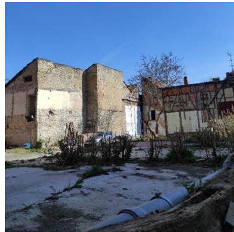
Abbildung 102: Brache Losengasse (Quelle: ProjektStadt 2022)
