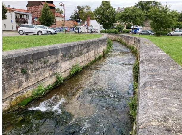
Abbildung 67: Schwemmnote heute im Hanfsack (Quelle: ProjektStadt 2021)
