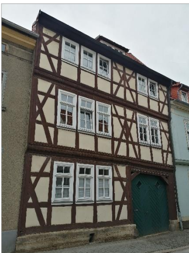
Abbildung 46: Burgstraße 21 - Fachwerkreilegung erfolgt
