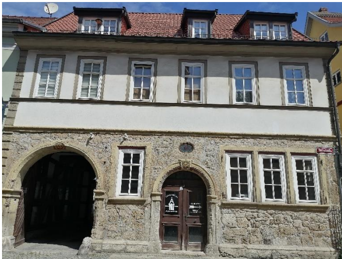
Abbildung 48: Holzstraße 7- saniert ohne Fachwerkreilegung
