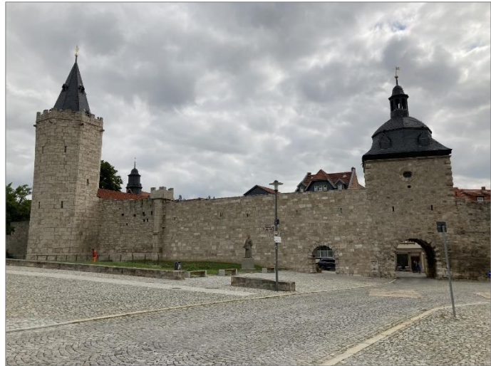
Abbildung 3: Westliche Stadtmauer mit Innerem Frauenturm, Rabenturm und befestigten Wallanlagen am Blochbach, 2021
