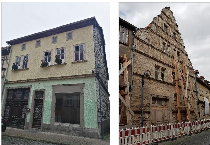
Abbildung 49: Herrenstraße 18, Wahlstraße 69 - unsaniert
