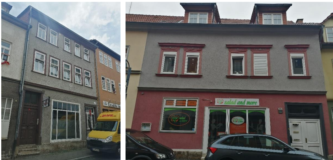
Abbildung 40: Jüdenstraße 8, Röblingstr. 15 (hier auch unpassende Differenzierung des Sockels)
