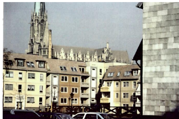
Abbildung 17: Zustand 1991 (Quelle: ROB Architekten + Stadtplaner 1991: 25)
