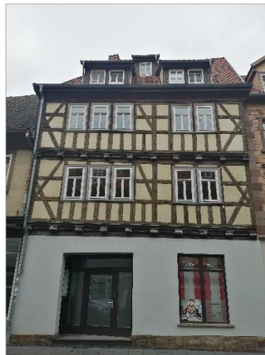
Abbildung 45: Felchtaer Straße 26, Görmarstraße 62 - Fachwerkreilegung erfolgt
