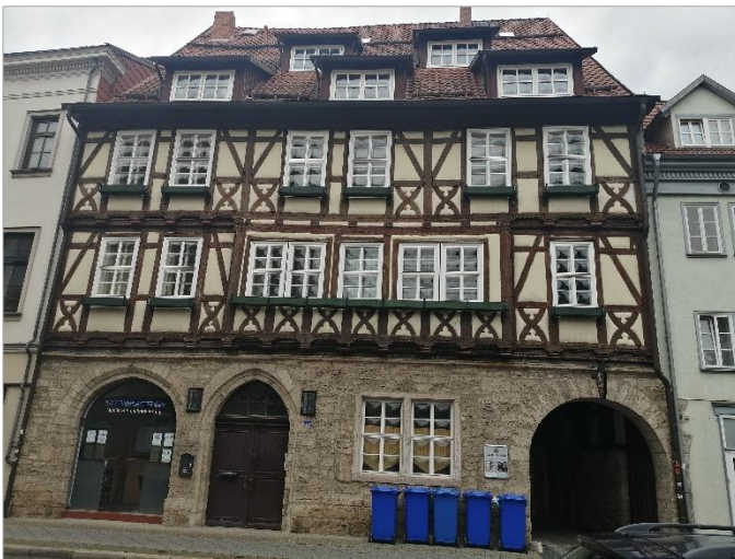
Abbildung 45: Felchtaer Straße 26, Görmarstraße 62 - Fachwerkreilegung erfolgt
