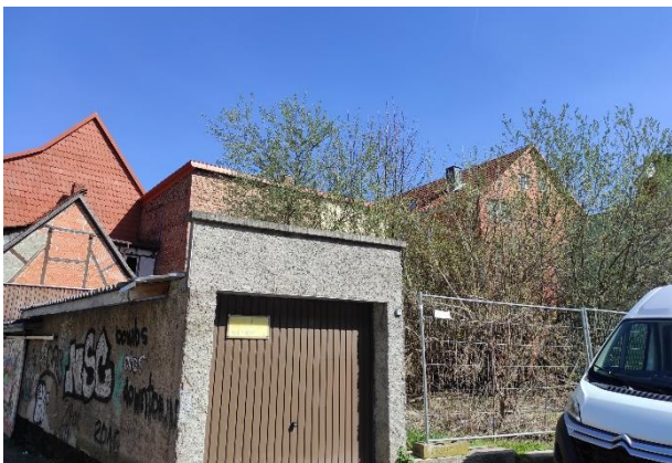
Abbildung 4: Brache Hinter der Mauer/ Breitenstr. (Quelle: ProjektStadt 2022)
