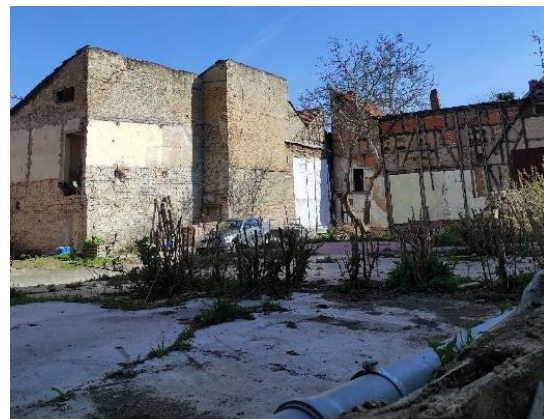
Abbildung 5: Brache Losengasse (Quelle: ProjektStadt 2022)
