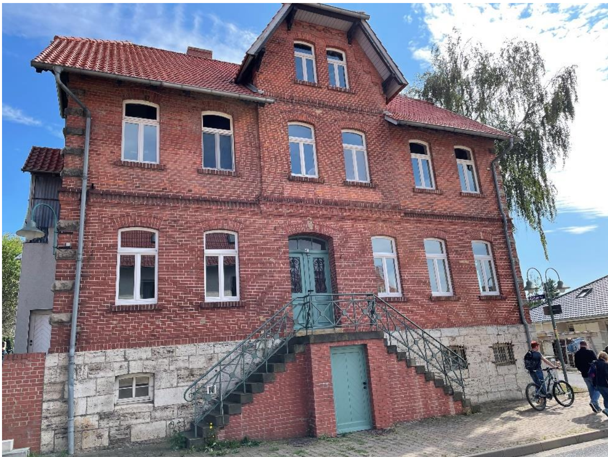
Sichtmauerwerk in Grabe
