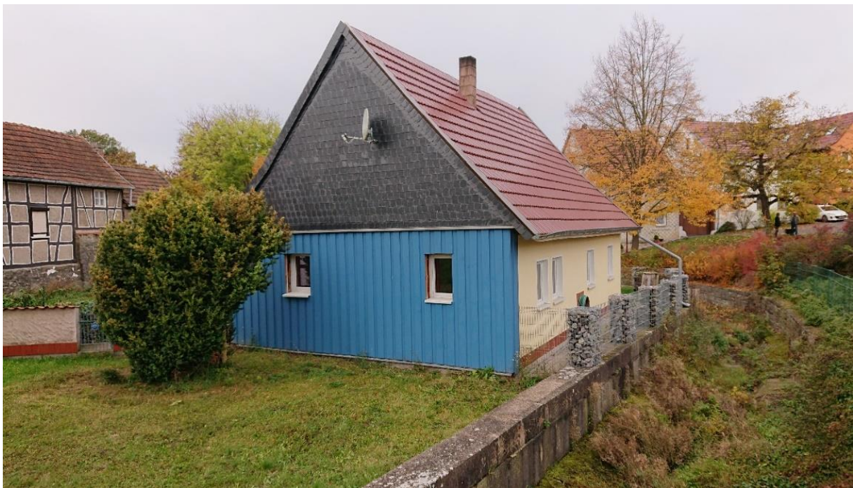
Giebelseite Dach mit Schieferverkleidung und Giebelseite Wand Blauanstrich der Holzfas- sade
