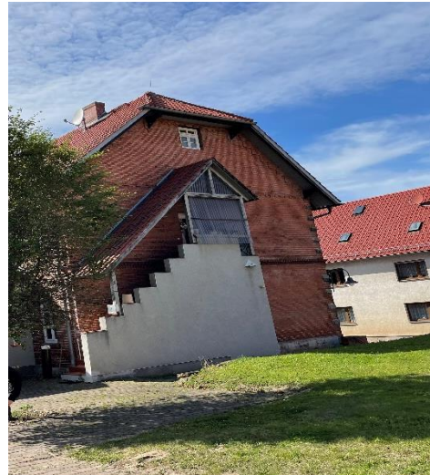
Krüppelwalmdach Saalanbau
