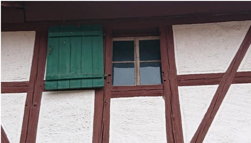
Fenster mit Sprossenteilung und Holzrahmen sowie Fensterläden im Fachwerkhaus in Grabe
