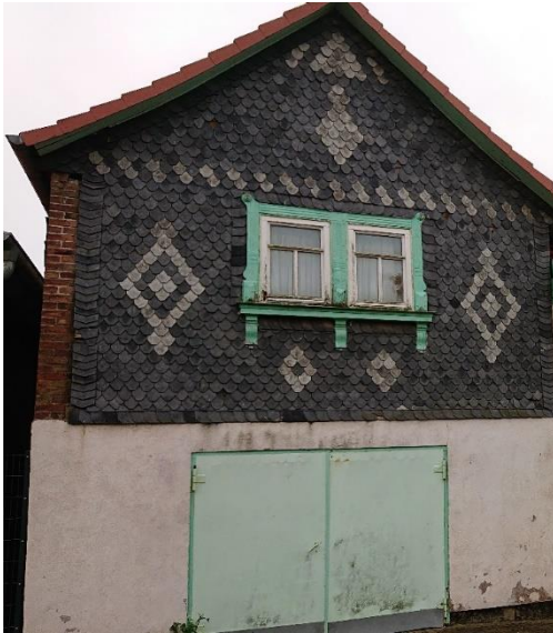
Fassade mit Schieferverkleidung in Saalfeld
