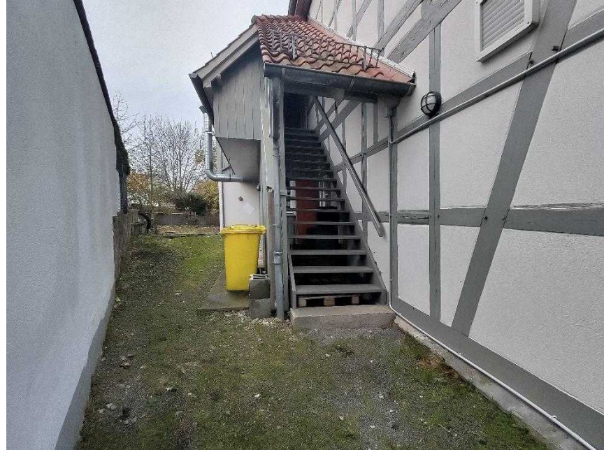
Abb. 20: Freitreppe an der Nordfassade des Bürgerhauses, welche durch einen Lift ersetzt werden soll
