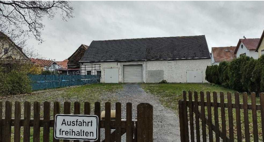
Abb. 21: aktueller Zustand des Bauhofgebäudes Höngeda
