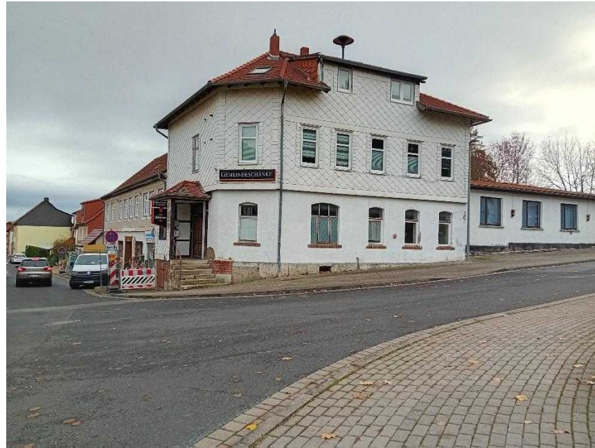
Abb. 26: Gemeindeschänke Felchta von außen
