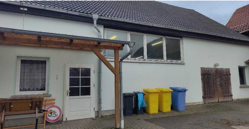
Abb. 22 aktueller Zustand des Bauhofgebäudes Höngeda
