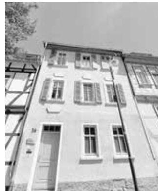
Foto: Stadt Mühlhausen Gebäudetechnik.
