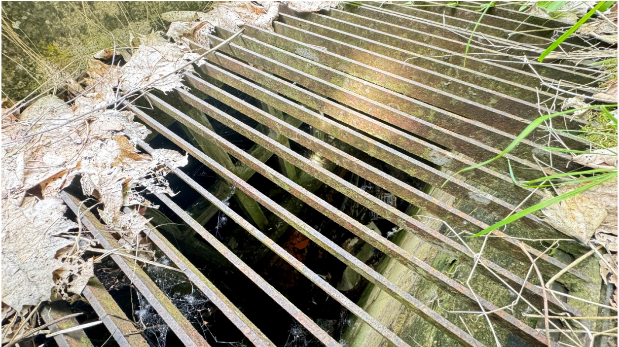
Abbildung 2: Lichtschacht und Unterkellerung der ehemaligen Bebauung
