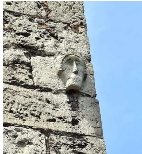
Abb.4: Kopfreief an der Nordostecke des Turmes. (2025) Foto: Thomas Nitz.
