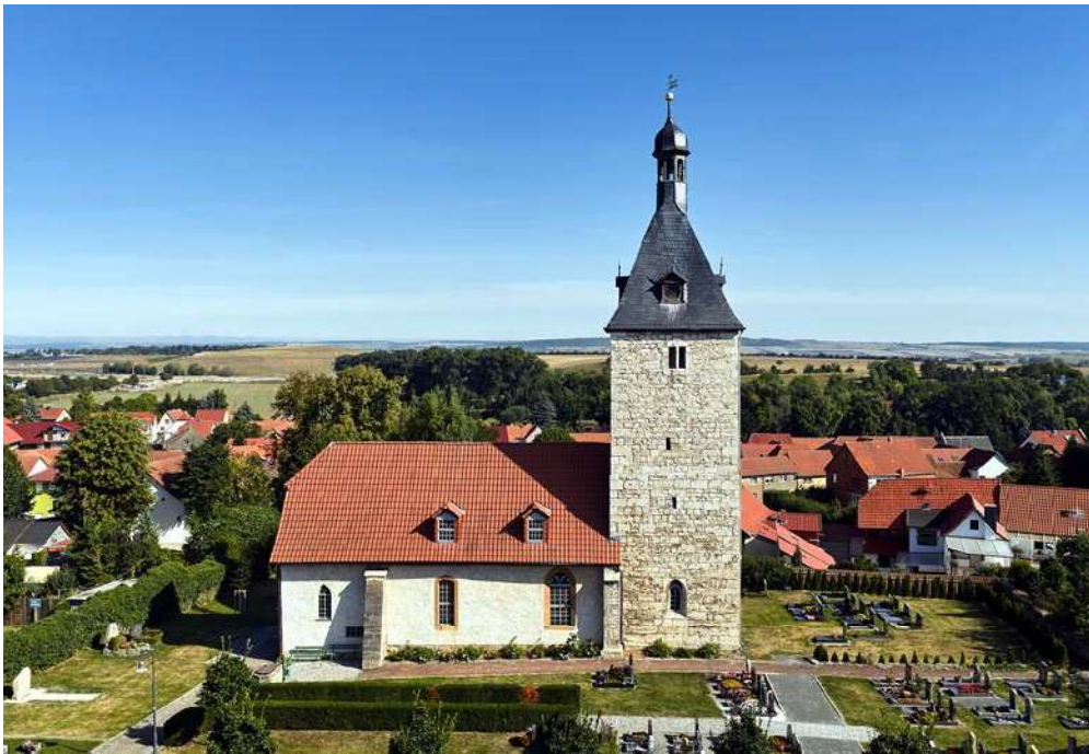
Abb. 2: Die Kirche von Süden mit dem Turm im Osten und den beiden Bauabschnitten des Langhauses, jeweils durch die Strebepfeiler abgegrenzt. Foto: Tino Sieland, StadtA Mühlhausen, 640/25/7/22.
