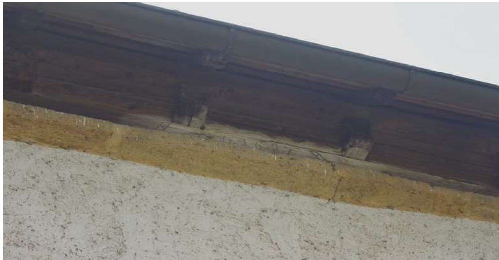
Abb. 3: Inschrift am Traufbalken der Nordseite über dem Fenster der Nordseitenpforte. (2025) Foto: Thomas Nitz.
